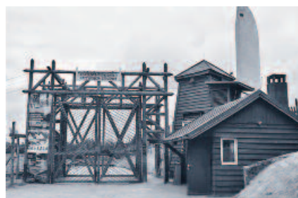
Eingangstor mit Wachhäuschen.
