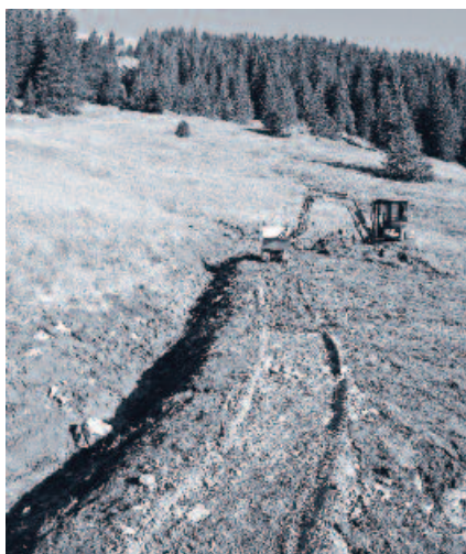
Unterhalt und Sanierung ist ständig erforderlich: Arbeiten am Weg zwischen dem Sunntäg und Chrummelbach.
