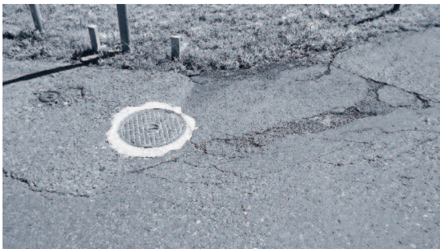
An der Hinterseestrasse / Diesselbacherstrasse wurden Risse und Belagsschäden repariert.
