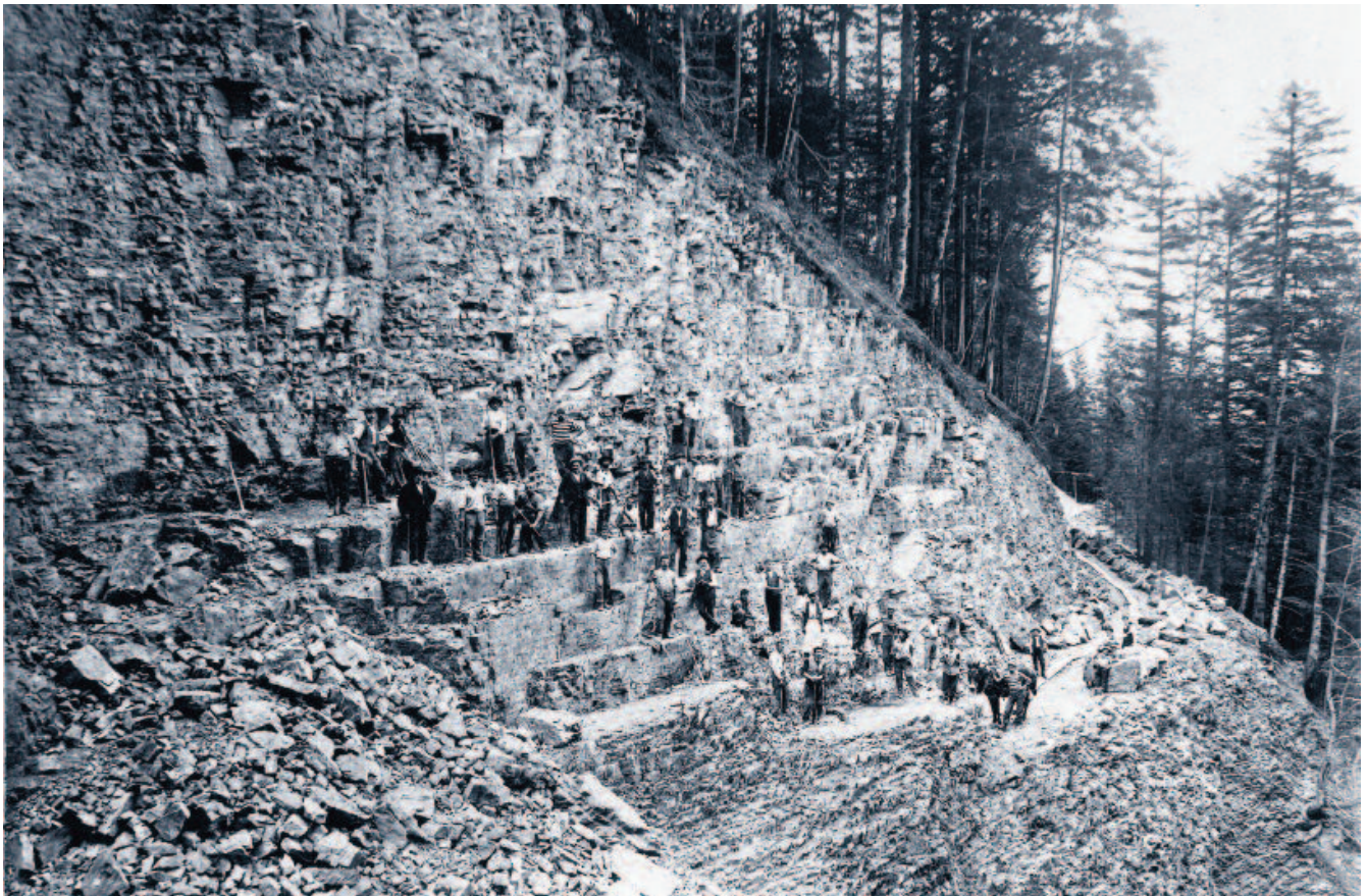
Bau der Strasse ins Kleine Melchtal beim Wendbachgraben.
