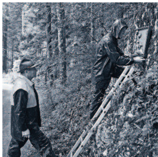
Bei misslichen Wetterverhältnissen wurden die Stationen an den Fels montiert.
