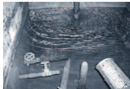
Sanierungsbedürftiger Druckbrecher.
