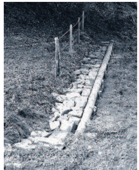
Ein Teil des sanierten Weges in den Sakramentswald.
