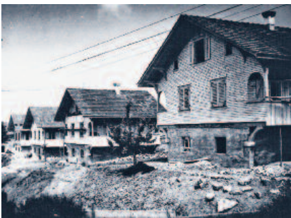
1925 erbauten die Gebrüder Gasser (später: Holzbau AG Lungern) fünf Einfamilienhäuser im zürcherischen Erlenbach. Die meisten dieser Häuser bestehen heute noch.
