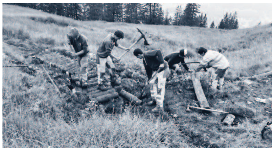
Auf weiteren Baustellen wurden Wanderwege verbreitert.
