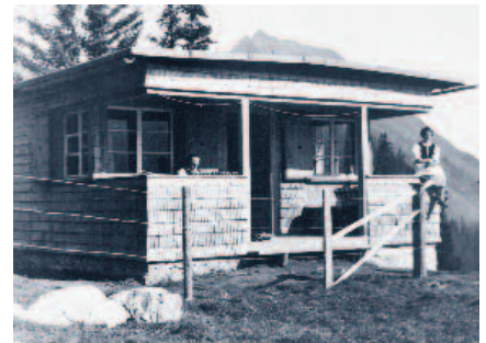
Typisiertes und grösstenteils vorfabriziertes Ferienhaus, das heute noch auf der Alp Krummelbach als solches genutzt wird.
