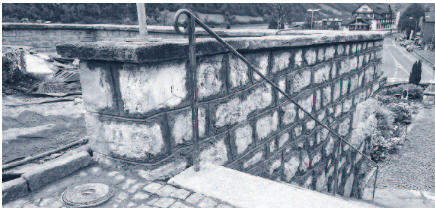
Die Friedhofsmauern der 2. Etage wurden saniert.
