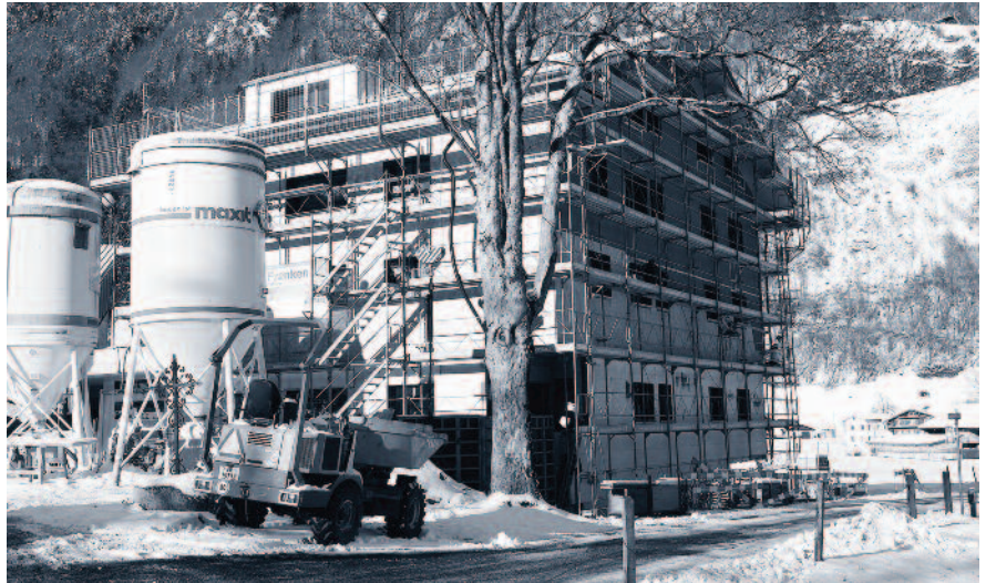
Die Baustelle bei der Talstation: Seit dem 11. Januar wird der Innenausbau ausgeführt.
