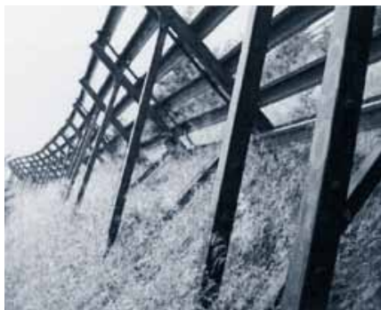
Detailaufnahme Abstützung Stahl-Schneebrücke.
