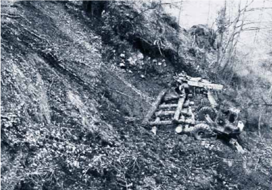
Einbau des untersten Holzkastens im Frühling 2001.
