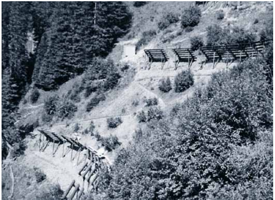
Husengraben: Stahl-Schneebrücken und Begehungsweg.
