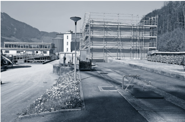
Rechts der Gasspeicher.
