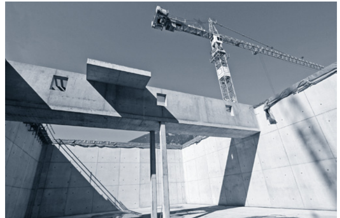
Blick aus einem der SBR-Becken.
