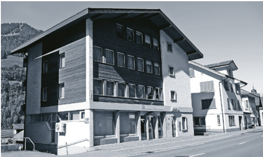
Das Gemeindehaus wird saniert. Während dieser Zeit wird die Gemeindeverwaltung ein Provisorium im Schulhaus Grossmatt beziehen. Foto: Rolf Halter
