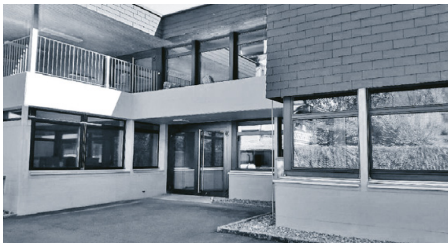
Voraussichtlich ab Anfang Januar 2018 bezieht die Gemeindeverwaltung das Provisorium im Erdgeschoss vom Schulhaus Grossmatt am Gräbliweg 4.
