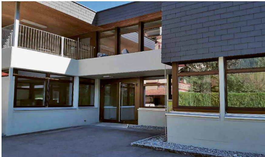
Seit Anfang Januar 2018 ist die Gemeindeverwaltung im Provisorium des Erdgeschosses vom Schulhaus Grossmatt am Gräbliweg 4.
