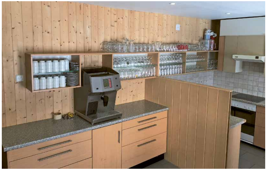
Im Frühling 2018 wurde im Schützenhaus Chnewis eine neue Küche eingebaut.
