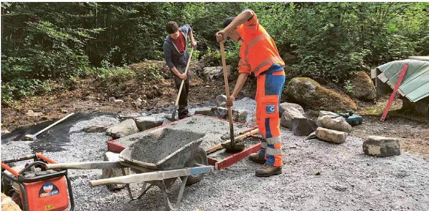
Betonarbeiten an der Grillstelle.
