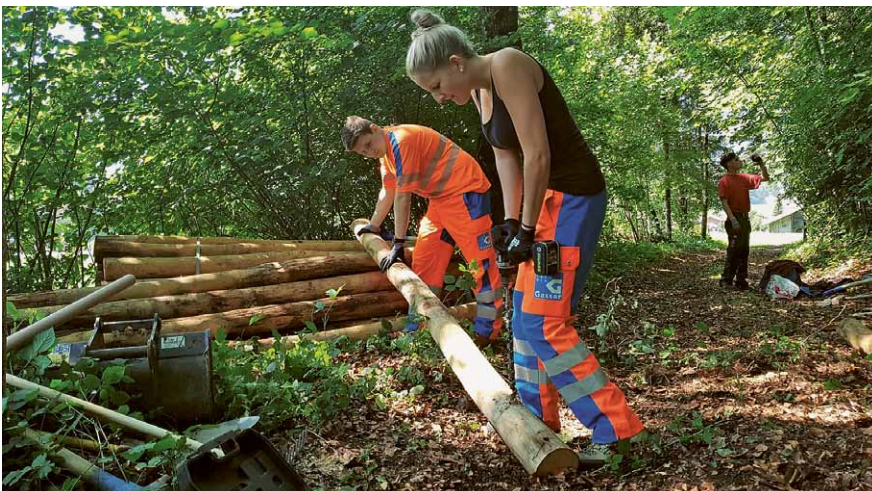
Bohren der Sicherungstämmen.
