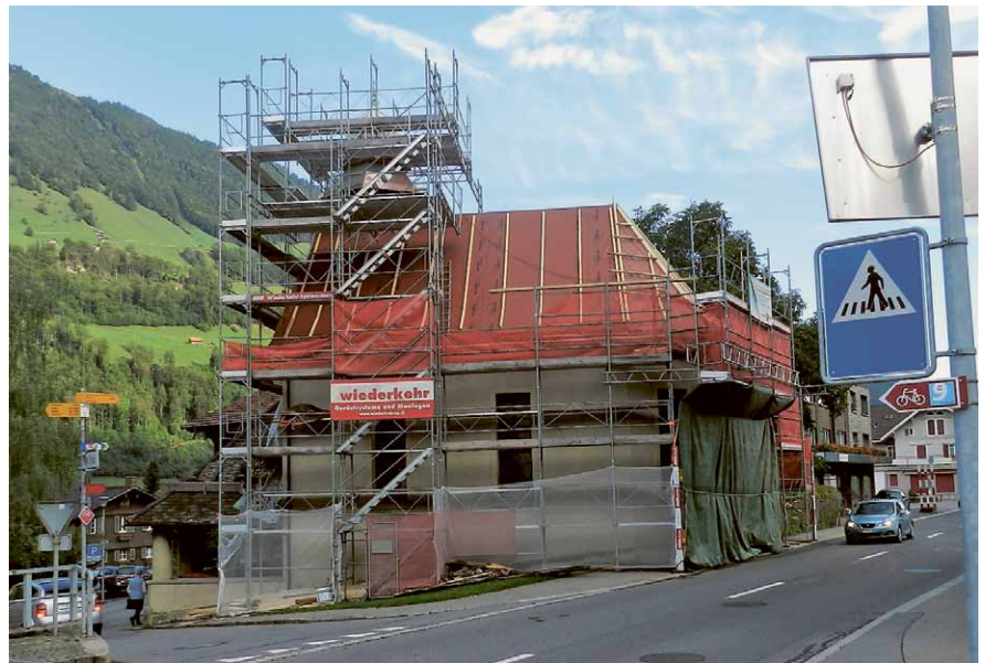
Die Dorfkapelle steht für die Dachsanierung im Vollgerüst.
