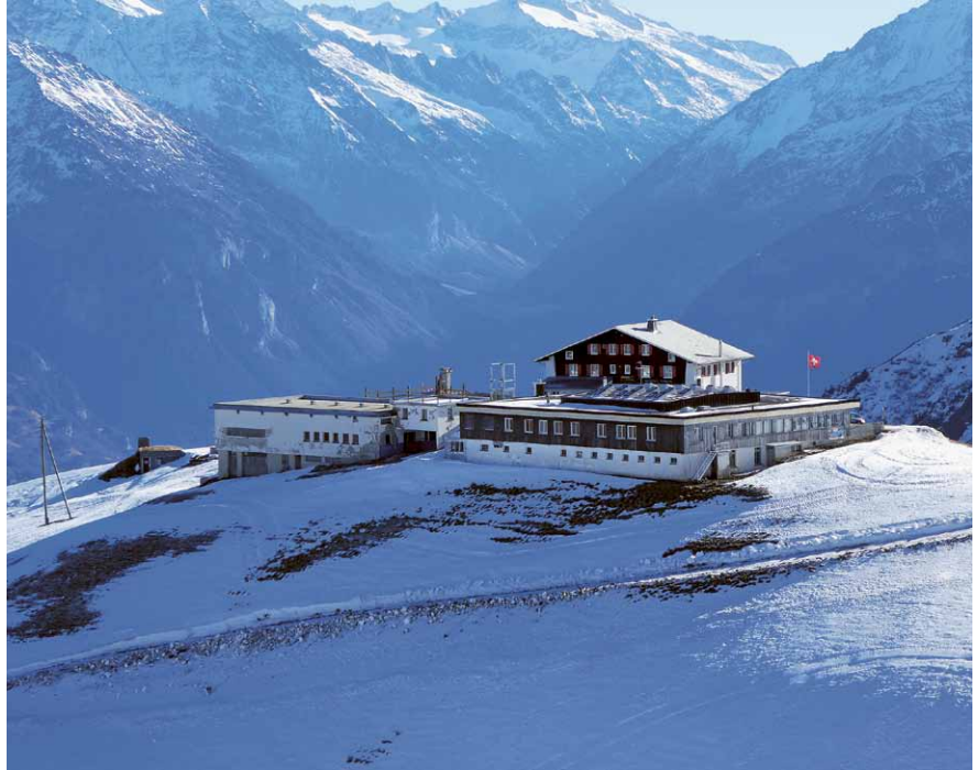
Die Bergstation der Gondelbahn (links) und das Sporting (rechts vor dem Berghaus Schönbüel) werden rückgebaut.
