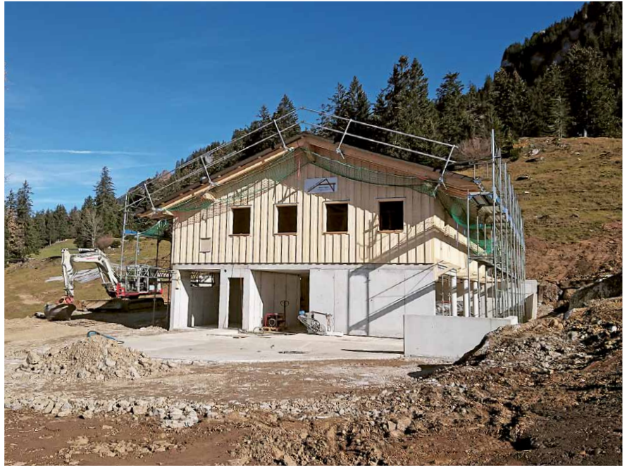
Neubau einer Alphütte im Unteren Feldmoos.
