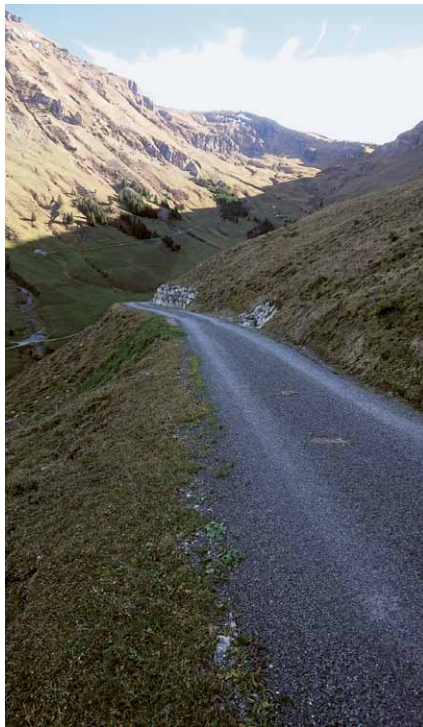
Die Chrummelbacher Strasse wurde von der Melchaa bis zur Alp hinauf komplett saniert.
