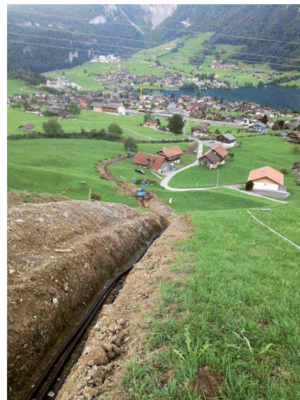
Das Projekt umfasst auch ca. 1200 Meter Grabenarbeit.
