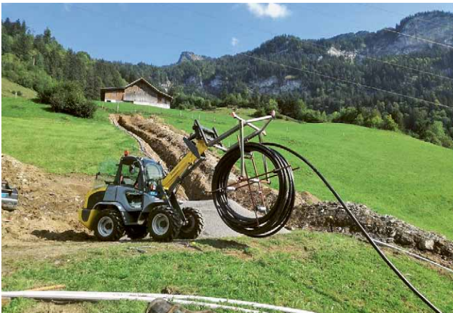
Verlegung von Wasserleitungen.
