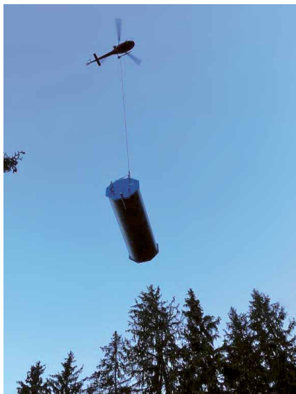
Reservoir wird mit dem Helikopter transportiert.
