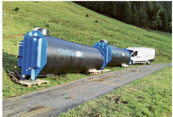
Zwei der drei Reservoir Tanks zu je 8000 Liter Fassungsvermögen.
