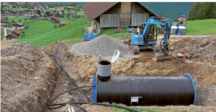
Projekt Rüti: Sanierung der Reservoirs und Brunnstube.
