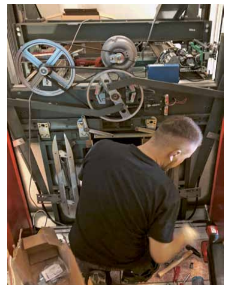
Einbau der neuen Liftsteuerung.
