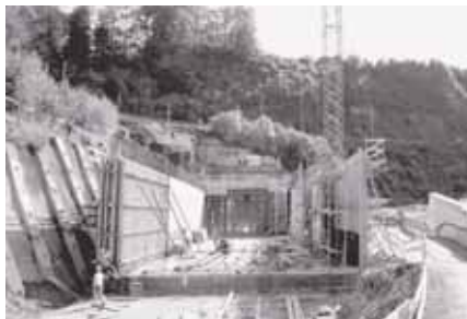
Tagbautunnel-Abschnitt beim Nordportal.
