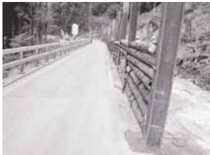
Arbeiten Brünigstrasse oberhalb Südportal.
