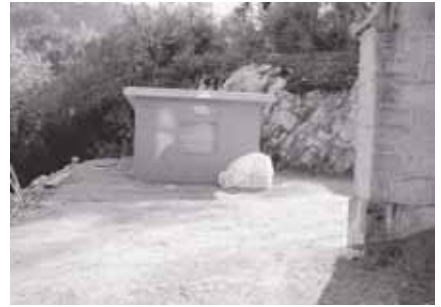
Baustelle Ersatzbau Ökonomiegebäude bei Kirche.
