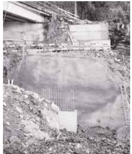
Foundation neue Brücke beim Südportal.
