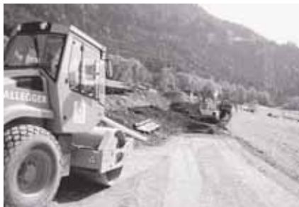
Baustelle neues Reservoir Röhrlü für Tunnel.
