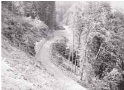
Neue Zufahrt Liegenschaft Brand.
