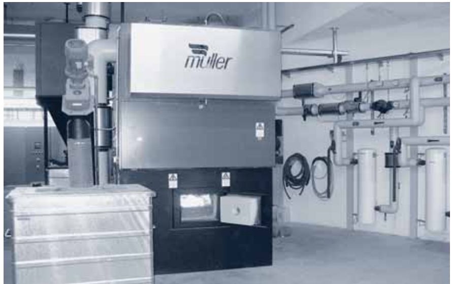
Holzschnitzelheizung, wie sie im Herbst 2008 auch in Lungern in Betrieb kommt.
