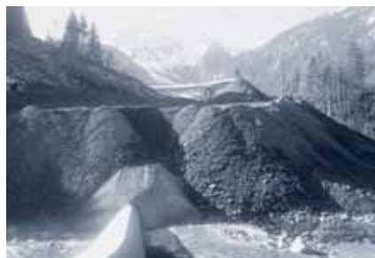
Deponie Hinti, bereits über 80'000 m 3 Material eingebracht.
