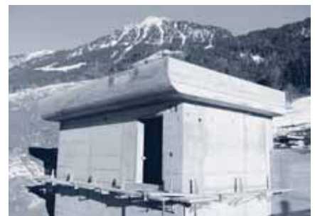
Reservoir Röhrl im Rohbau erstellt.
