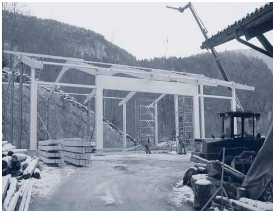
Aufrichten der neuen Halle.
