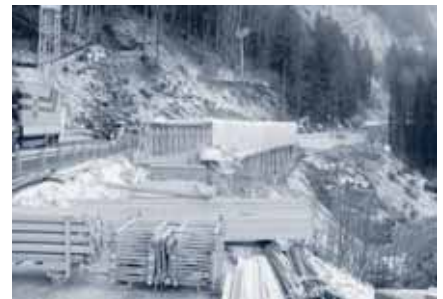
Lehenbrücke beim Südportal mit Schutzdach für Abdichtungsarbeiten.
