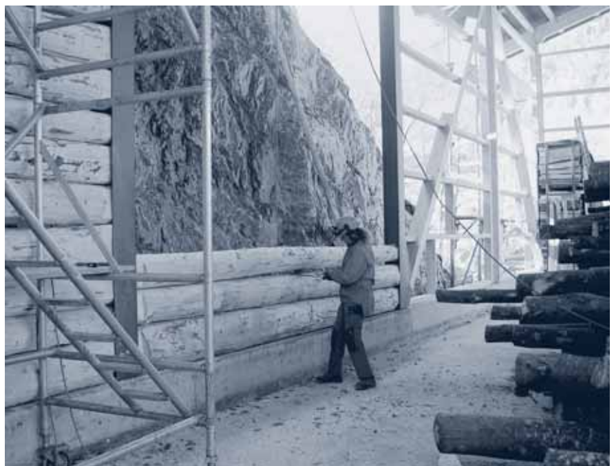
Die neue Halle von innen.
