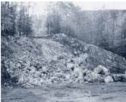
Felsabbau vor Beginn des Hallenbaus.
