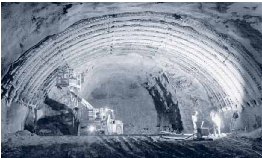
Felssicherungsarbeiten in der 1. Ausstellnische.
