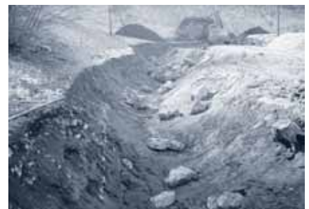
Aushub Bachprofil Höllbach.
