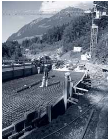
Armierung der Lehnbrücke beim Südportal.
