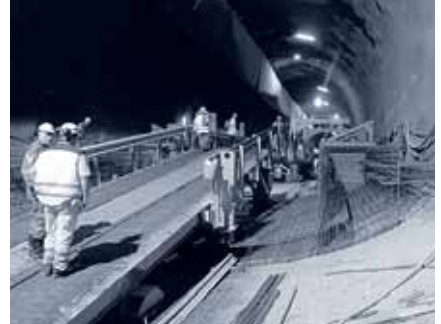
Betonieren des Sohlgewölbes unter der speziellen, verschiebbaren Installationsbrücke.
