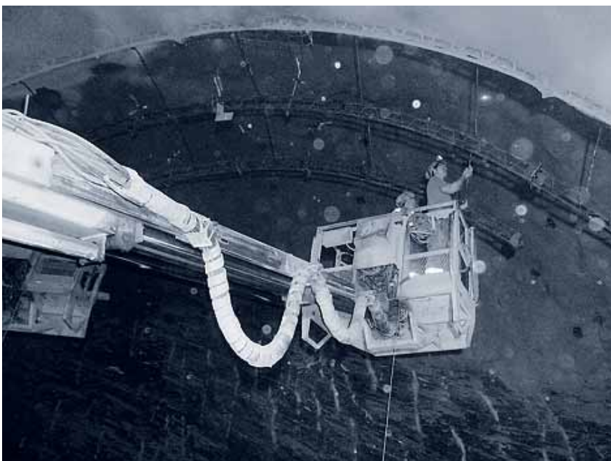
Stahleinbauten in der geologisch heikeln Zone.
