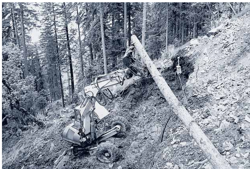
Strasse sichern mit Holzkasten.
