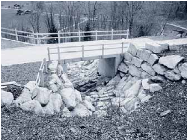
Durchleitung Schwendlenstrasse nach der Sanierung.
