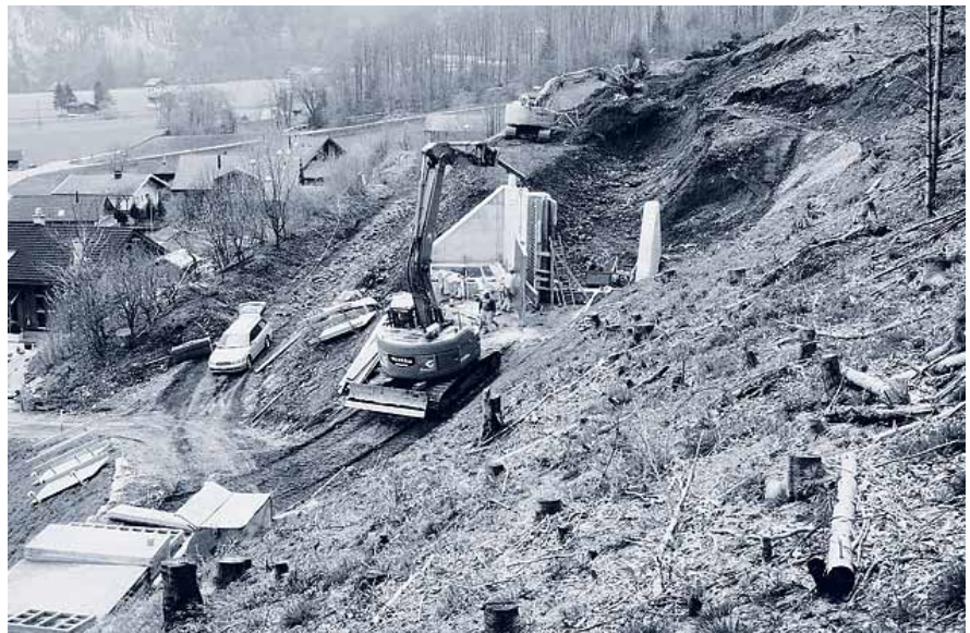
Bau des neuen Auffangbeckens mit befahrbarem Dammabschluss.
