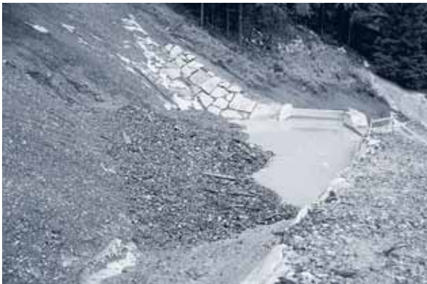
Auffangbecken nach dem Hagelwetter vom 1. Juli 2008.
