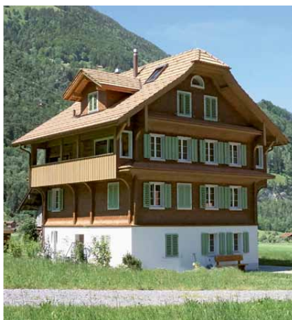
Ansicht Süd-West, nach Sanierung, 2020.
