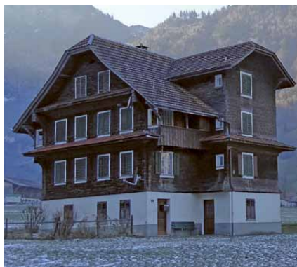
Ansicht Süd-Ost, vor Sanierung, 2016.
