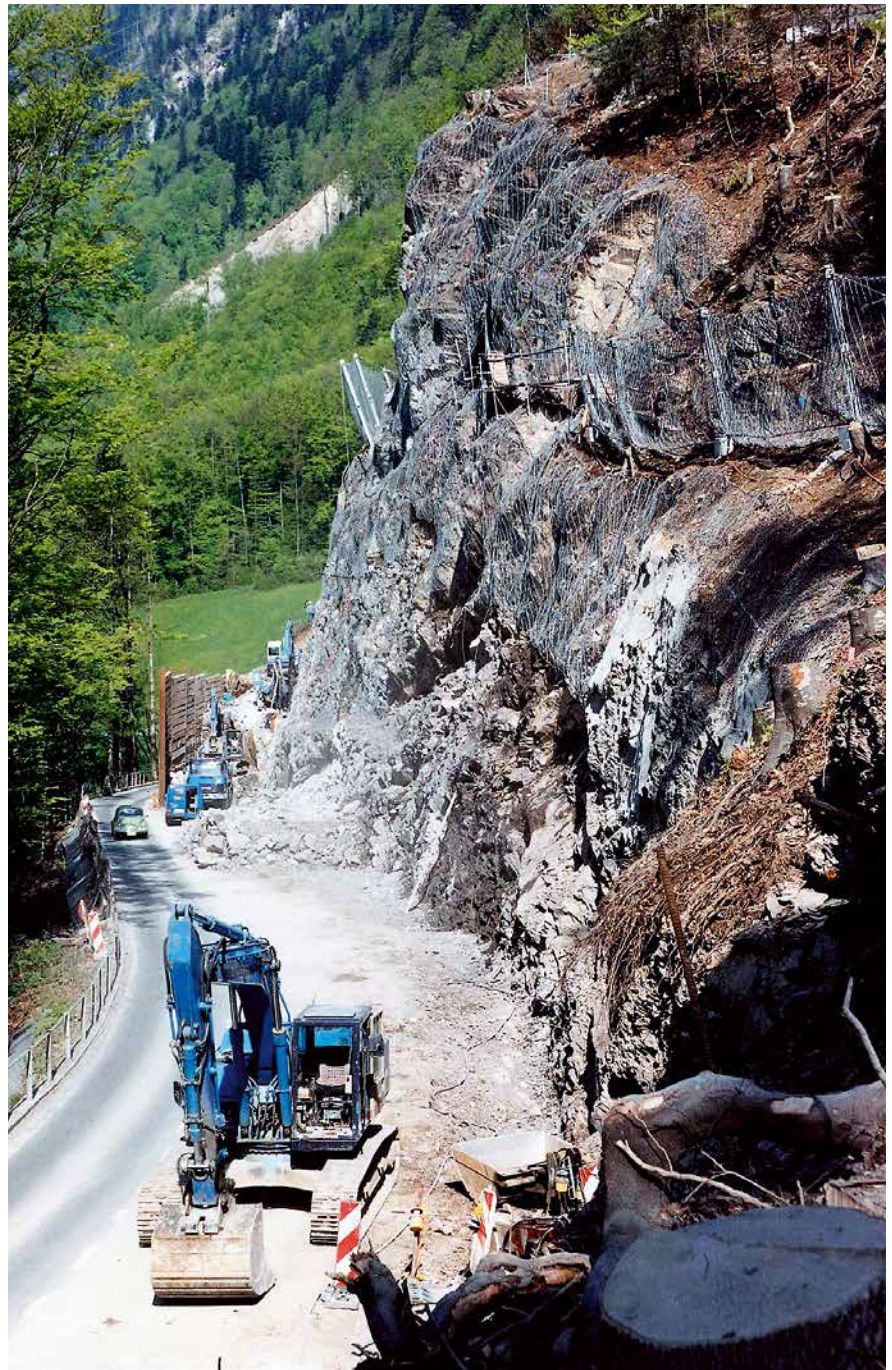
Felsabbau und Steinschlagschutz an der Brünigstrasse bei Kaiserstuhl, 1996.
