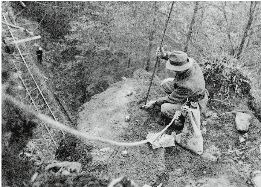
Gründer Karl Gasser-Meier beim Laden von Sprenglöchern über dem Trassee der Brünigbahn zwischen Kaiserstuhl und Lungern, 1959.
