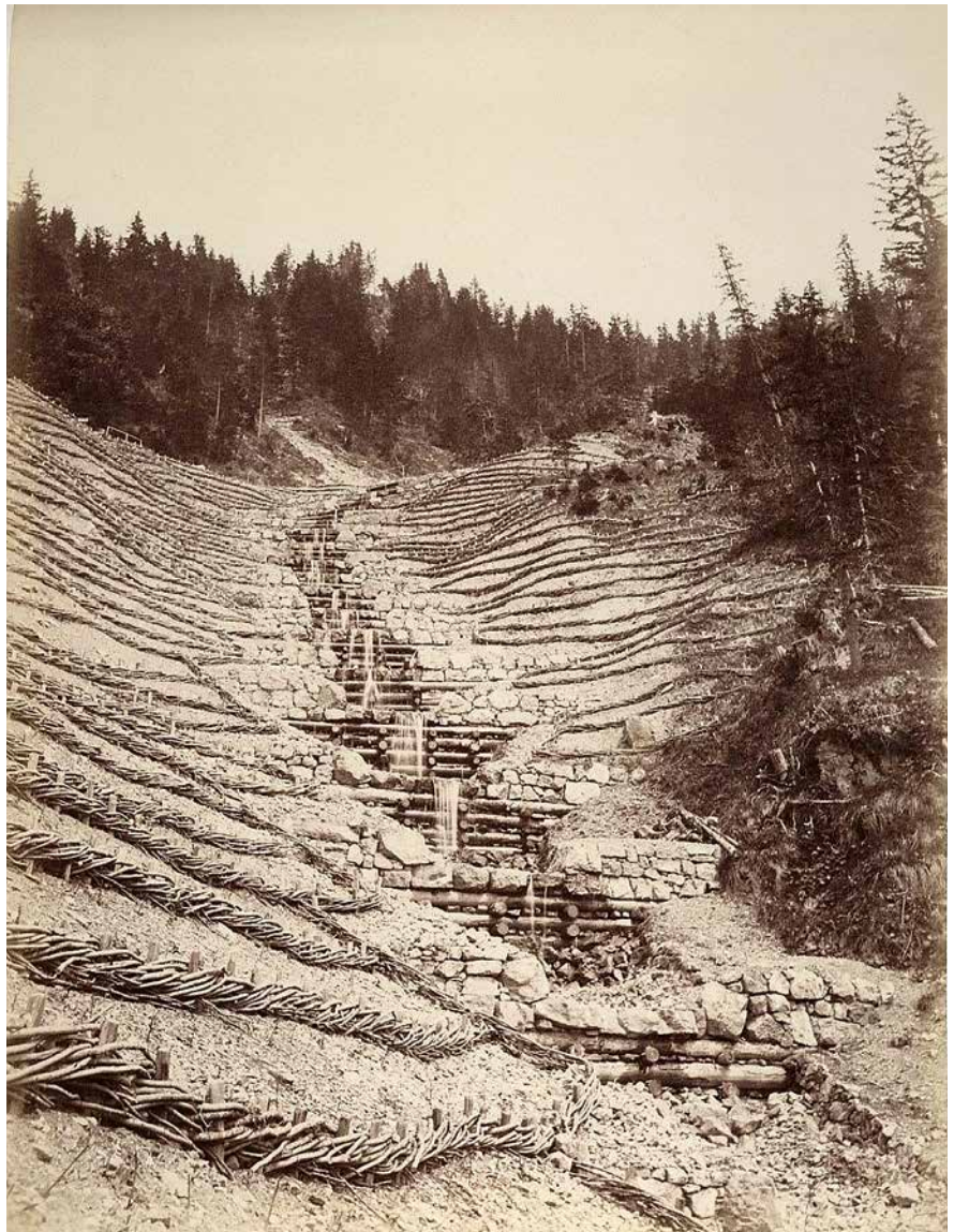
Erste Verbauungen Gadenmattbach auf ca. 1300 m. ü. M.
