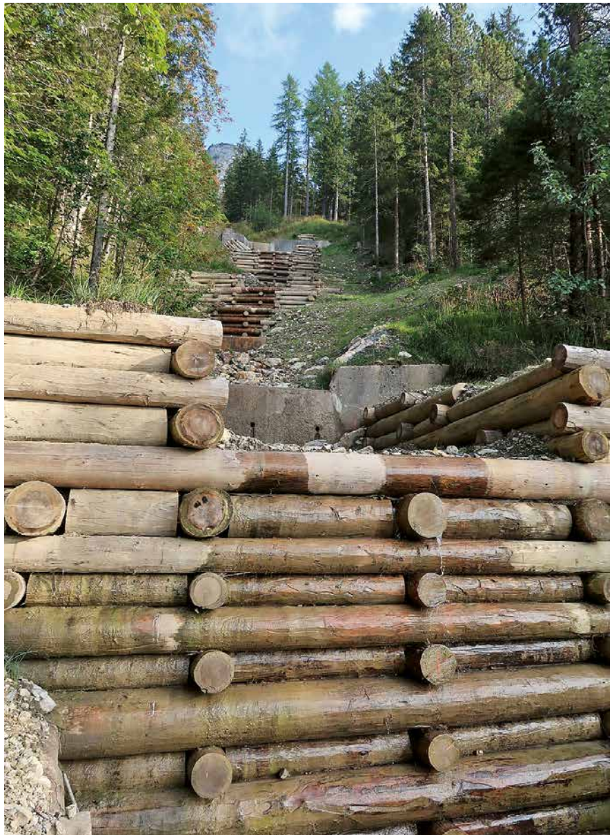
Neue Holzsperrn Gadenmattbach, die zwischen den alten Betonsperrn gebaut wurden.
