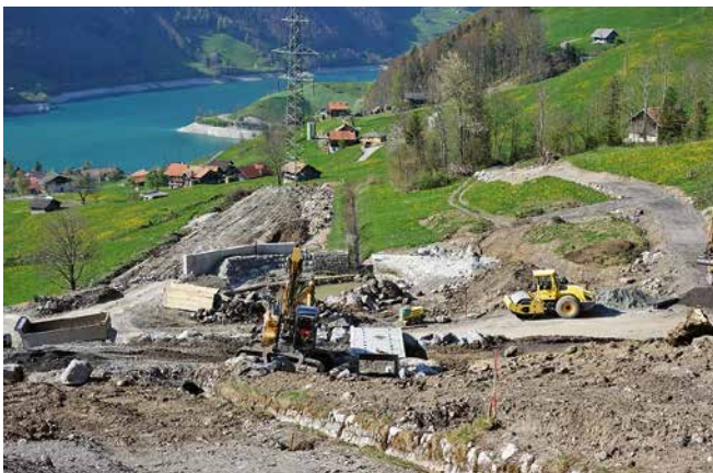
Bild links: Neubau Aglimattsammler Oktober 2013–Oktober 2014. Bild rechts: Der neue Aglimattsammler wird nach Bauende eine Kapazität für ein 300-jährig ausgelegtes Ereignis haben, d.h. für eine Geschiebefracht von ca. 4000–5000 m 3 .
