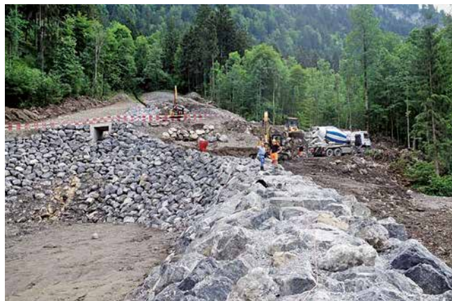
Bild links: Neubau Aglimattsammler Oktober 2013–Oktober 2014. Bild rechts: Der neue Aglimattsammler wird nach Bauende eine Kapazität für ein 300-jährig ausgelegtes Ereignis haben, d.h. für eine Geschiebefracht von ca. 4000–5000 m 3 .
