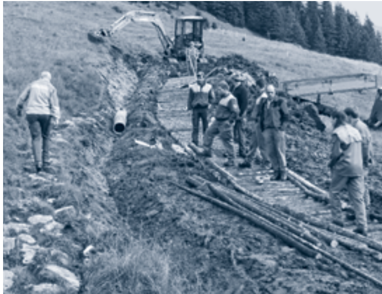
Sanierung des Wanderweges Chrummelbach–Sunnätäg.
