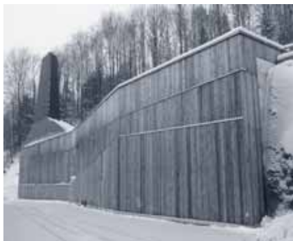
Holz statt Öl: Die Fernheizung in der Hackrä wird mit Holzsplitzel, Spänen und Holzabschnitten betrieben.
