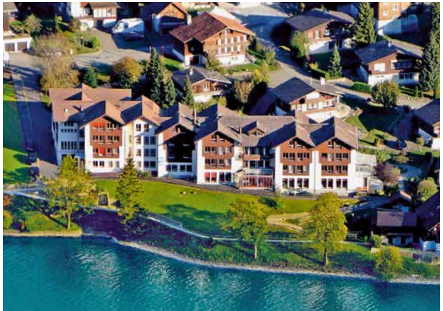
Das Eyhuis ist gut in das Dorfbild eingebettet und zudem direkt am See gelegen. Mit dem Umbau- und Sanierungsprojekt wird das Haus noch weiter aufgewertet.
