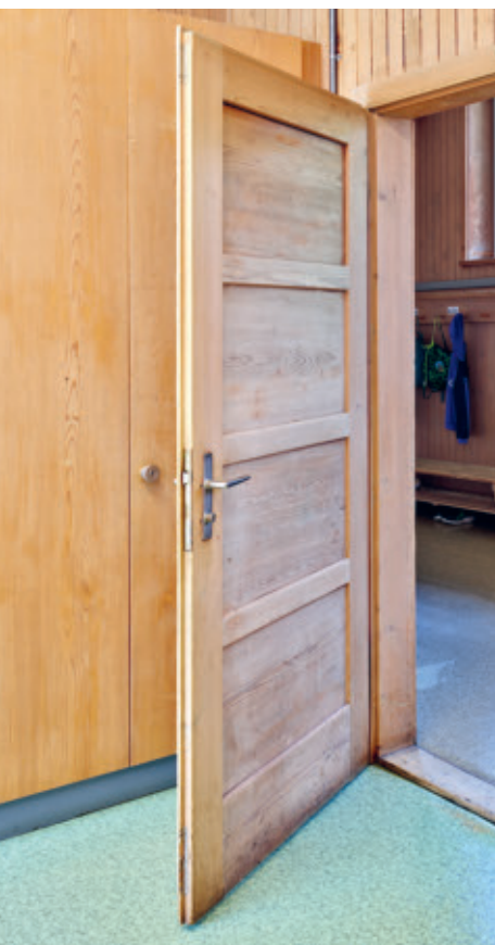
Mangelnder Brandschutz; nicht feuerbeständige Türen und Treppen, Fluchttreppen zu schmal
