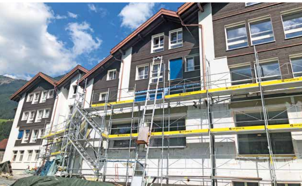
Die umfangreichen Bauarbeiten am Eyhuis nähern sich dem Abschluss.
