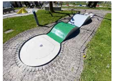
Die Bahnen der Minigolfanlage wurden instandgesetzt.
