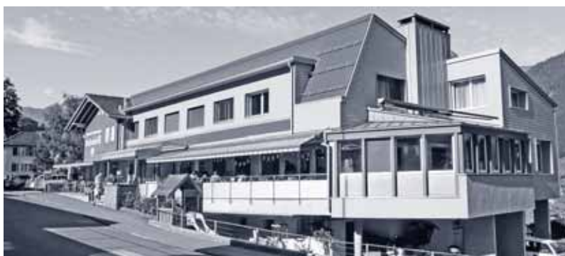
Das Bahnhöfli in moderner Optik mit neuem Dach.
