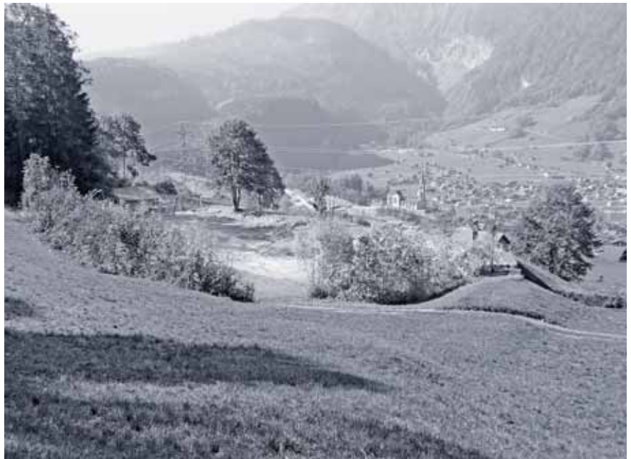
In einem grösseren Projekt wird der Aglimattsammler umgebaut.
