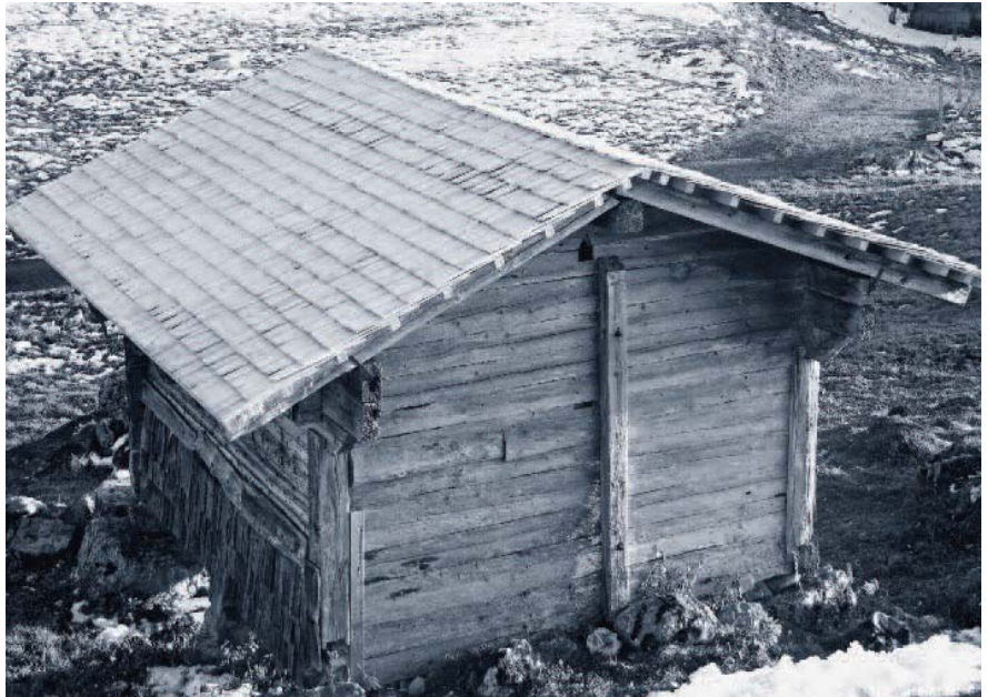
Bild oben und unten links: Das Schindeldach des Spychers auf Hüttstett musste neu gedeckt werden.
