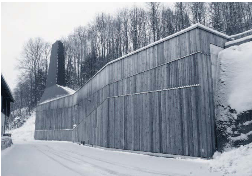
Das Elektrizitätswerk Obwalden EWO betreibt die Fernheizung in der Hackrä mit erneuerbarer Energie (Holzschnitzel, Späne und Holzabschnitte).
