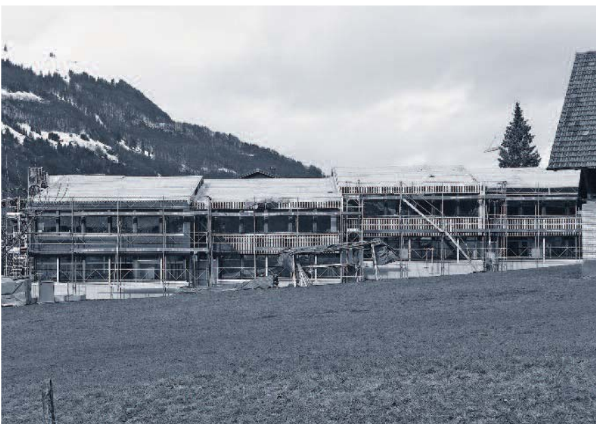
Die Schulhäuser sind Eigentum der Gemeinde und werden auf die Energiewerte geprüft.
