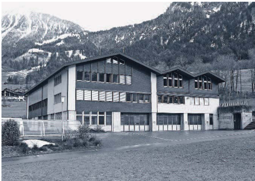
Das Mehrzweckgebäude wurde auf seine Energiewerte geprüft.
