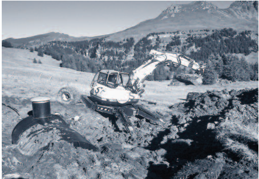
Versetzen der Wasserfassung auf der Alp Krummelbach.
