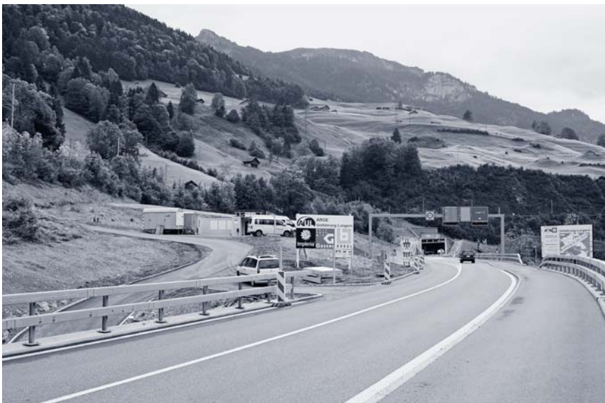
Nordportal Ende September 2012.
