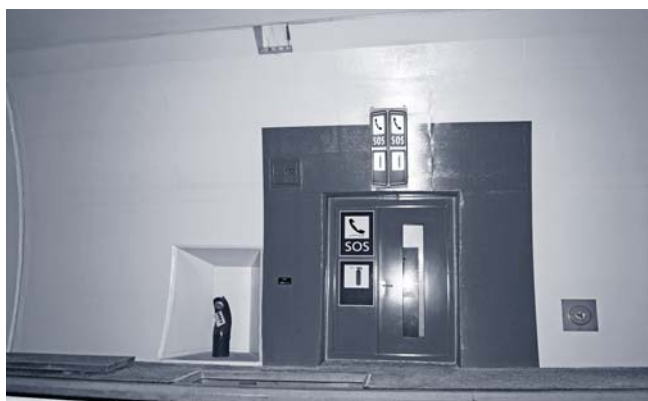
SOS- und Hydrantennische.
