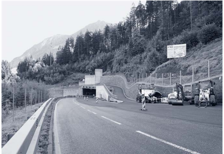
Südportal Ende September 2012.
