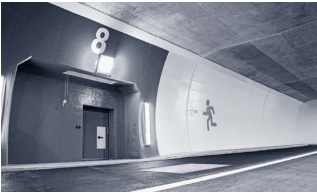
Querverbindung Nr. 8 in den Sicherheitsstollen.
