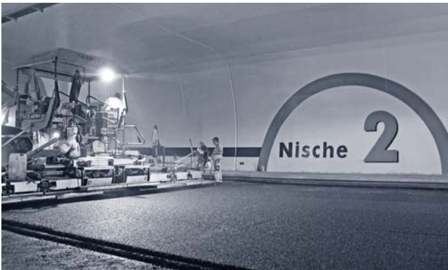
Einbau dunkler Walzasphalt.
