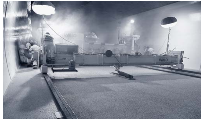
Einbau Gussasphalt, abgestreut mit hellem Splitt.
