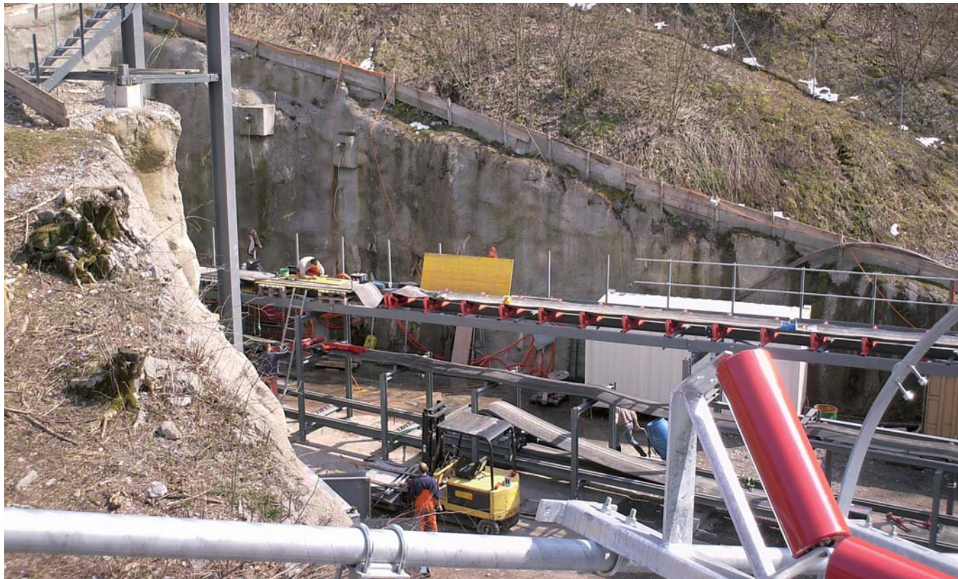
Die Schlussverbindung, angepasst auf die richtige Gurtlänge, wird ausserhalb des Südportals hinter dem Antrieb am Obergurt und im Bandspeicher am Untergurt durchgeführt.
