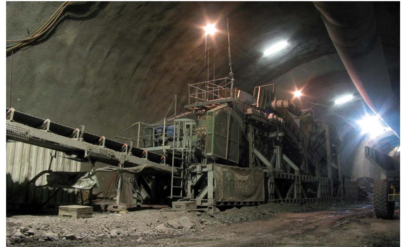
Die Brechanlage ist nun an ihren Einsatzort angekommen und bereit für das Zerkleinern des Tunnelgerölls.
