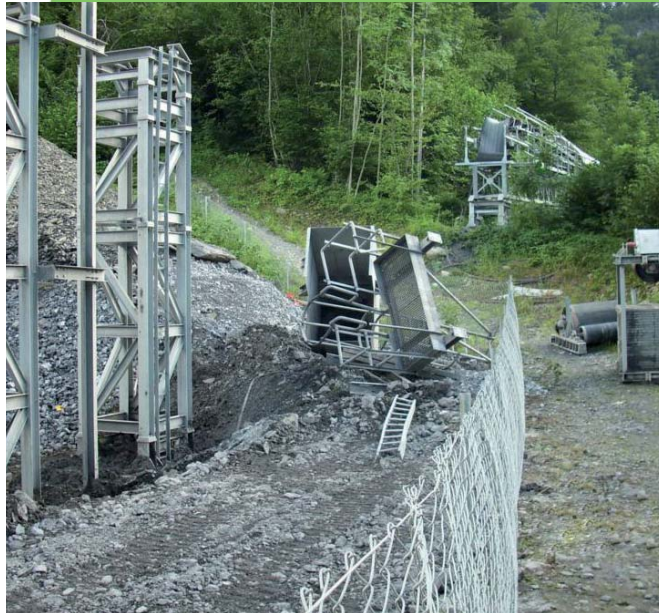
Bevor die Stützen zerlegt werden konnten, mussten die Arbeiter das Förderband und alles was dazu gehörte, abmontieren.
