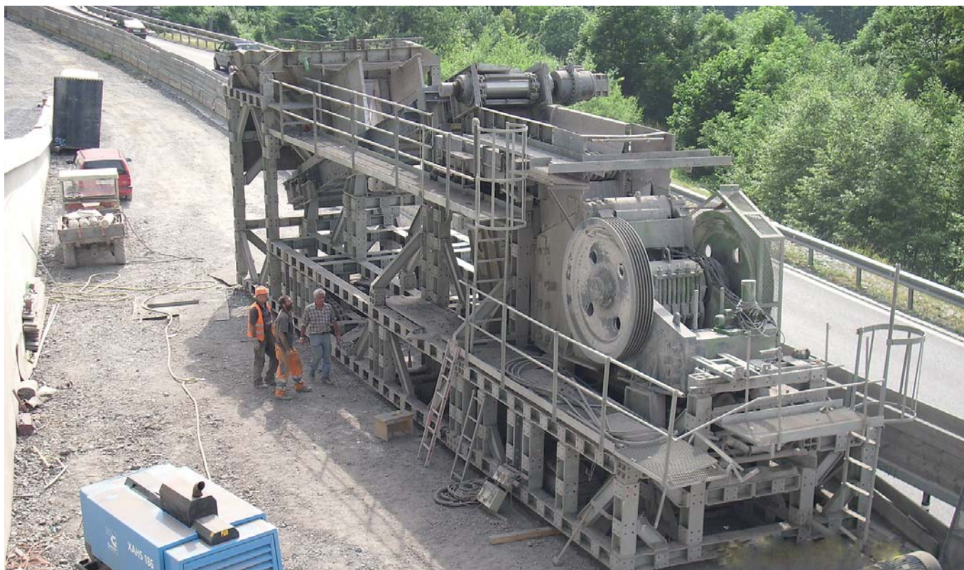
Bevor die Stützen zerlegt werden konnten, mussten die Arbeiter das Förderband und alles was dazu gehörte, abmontieren.
