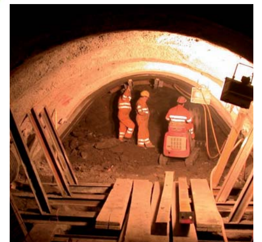
Die Tunnelarbeiter mussten mit einem Kleinbagger sowie von Hand Teile des Firststollens ausbrechen.
