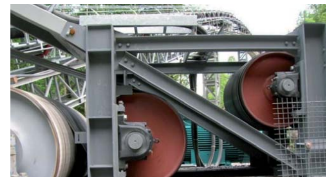
Die Lager der Trommeln müssen immer kontrolliert werden.
