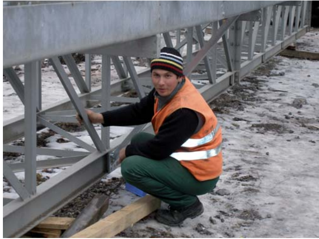
Vormontage der Bandedemente
