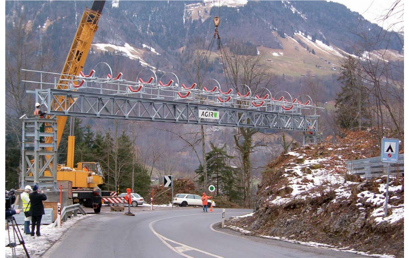
Hier wird mit einem Kran die Bandbrücke über die Brünigstrasse gehieft.
