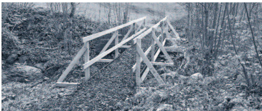
Die Brücke beim Voregggraben wurde durch den Zivilschutz erneuert.
