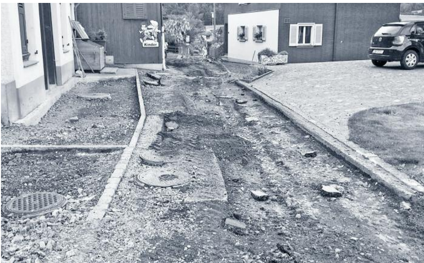
Bauarbeiten am Trennsystem im Unterdorf.
