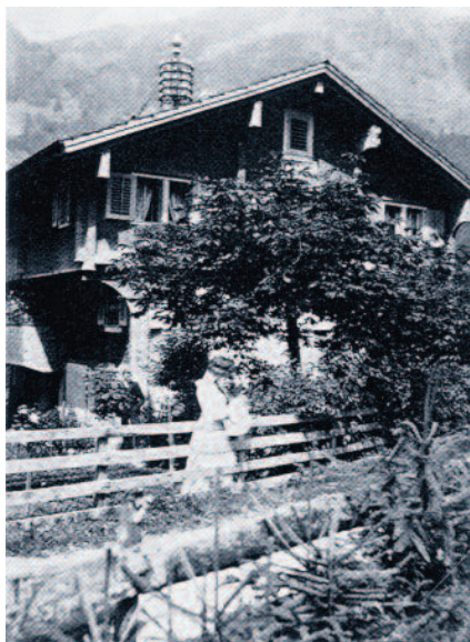
Posthaus unter der Dorfkapelle. Man beachte die Telegrafenanlage auf dem Dach.
