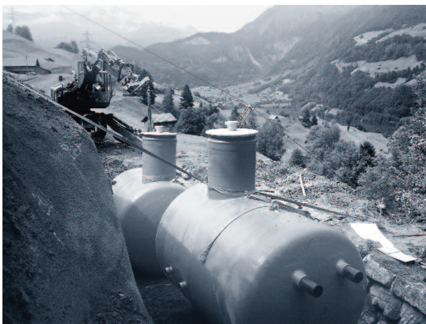
Verwurfsklappe und UV-Anlage im Husengraben.
