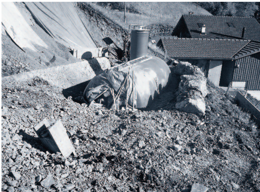
Reservoir Dieggis mit ca. 8 m 3 Wasserinhalt.
