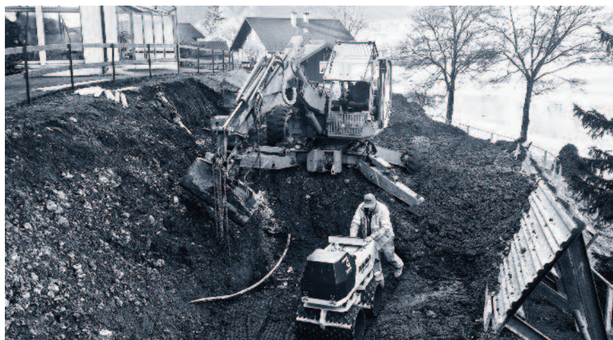
Als letzter Leitungsabschnitt wurde das Trennsystem beim Pumpwerk Eyhuis gebaut.
