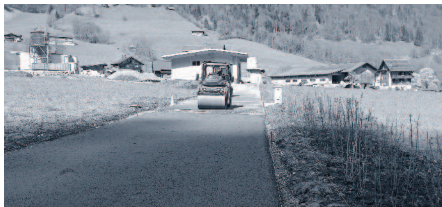
Erstellung der Tragschicht auf der Hagstrasse.
