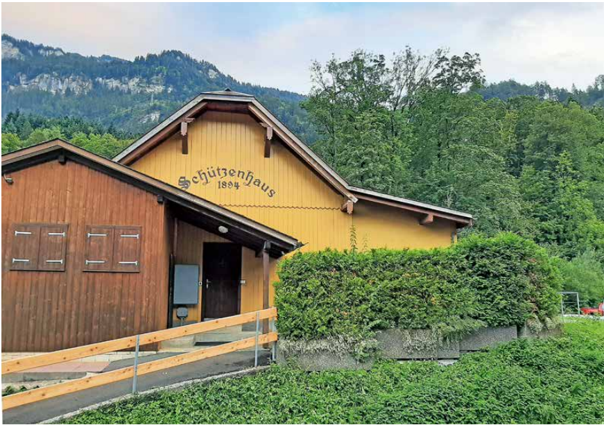
Das alte Schützenhaus im Chnewis wird derzeit sanft renoviert und umgebaut.
